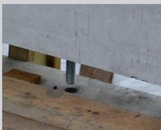
Untere Lagesicherung mittels eingedrehten Bolzen und Verguss mit vorbereiteten Aussparungen
